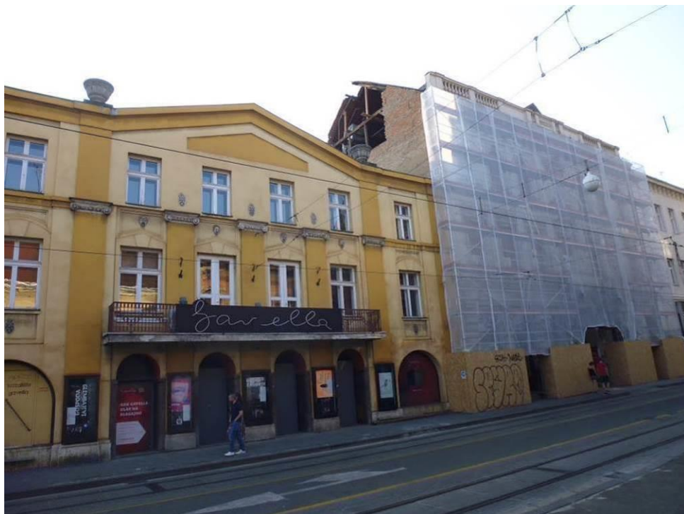
Potres u Zagrebu, 22. 3. 2020. - oštećene zgrade u Frankopanskoj ulici, uključujući i kazalište Gavella
