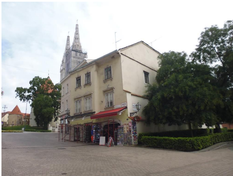
Oštećena zgrada u Bakačevoj
