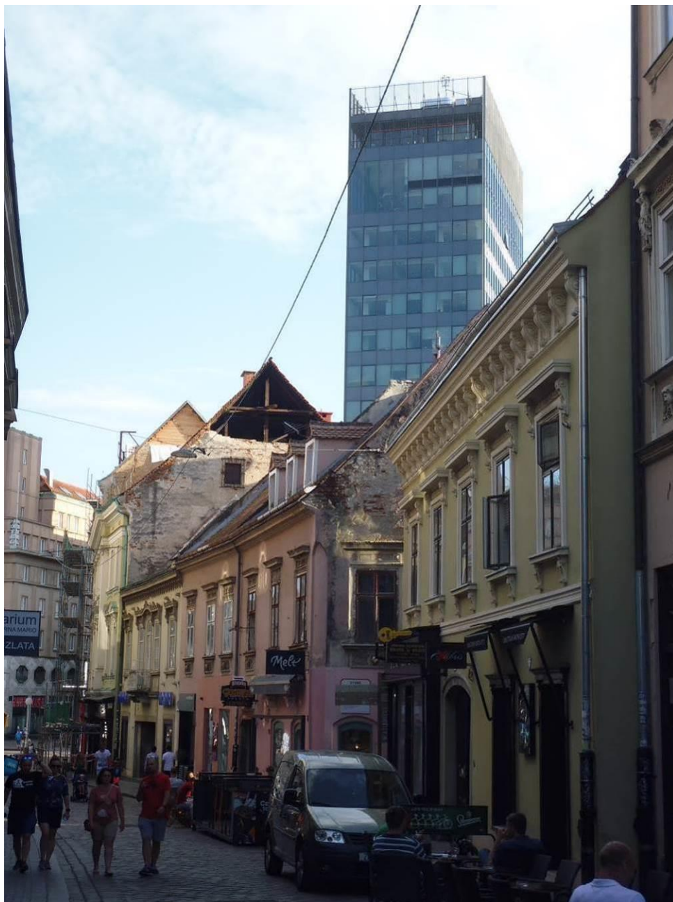
Potres u Zagrebu, 22. 3. 2020. - oštećena zgrada u ulici Pavla Radića
