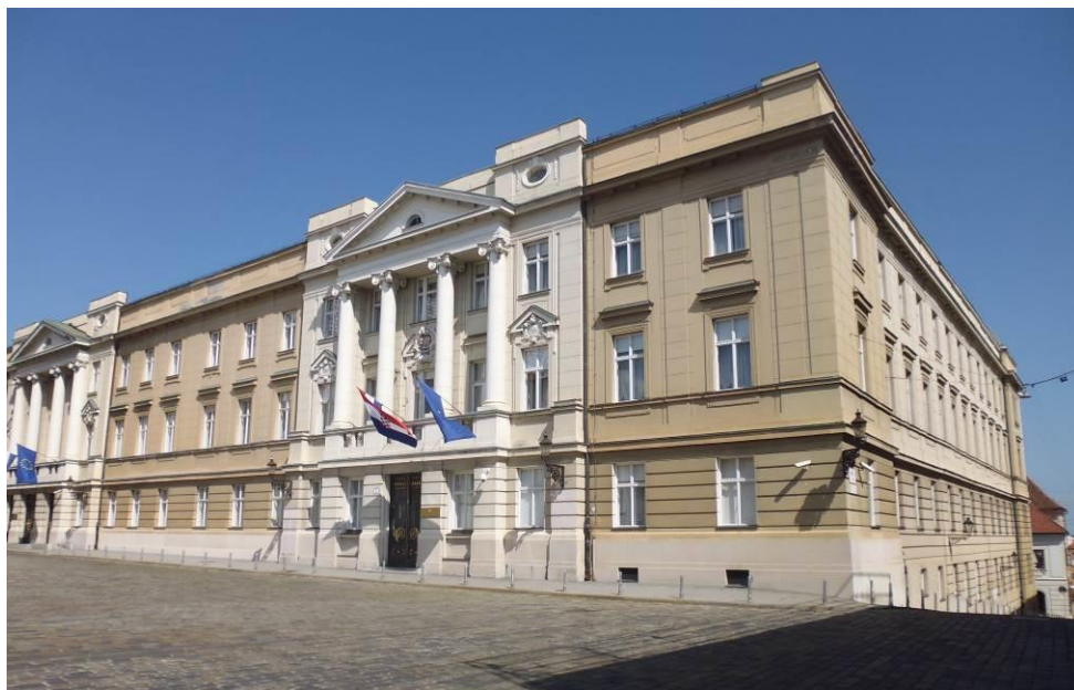
Zgrada Hrvatskog sabora oštećena u potresu
