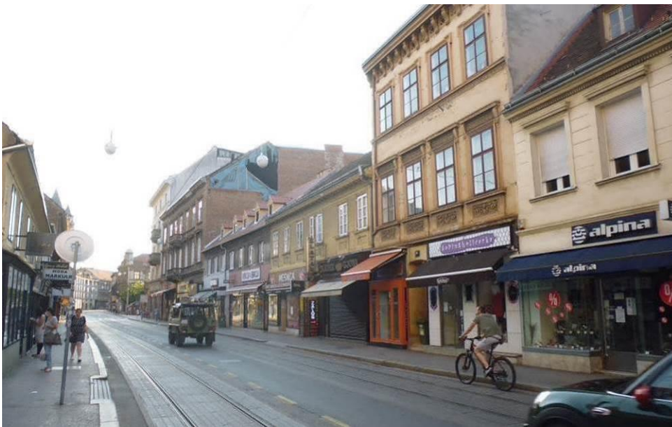
Potres u Zagrebu, 22. 3. 2020. - oštećena zgrada u Ilici
