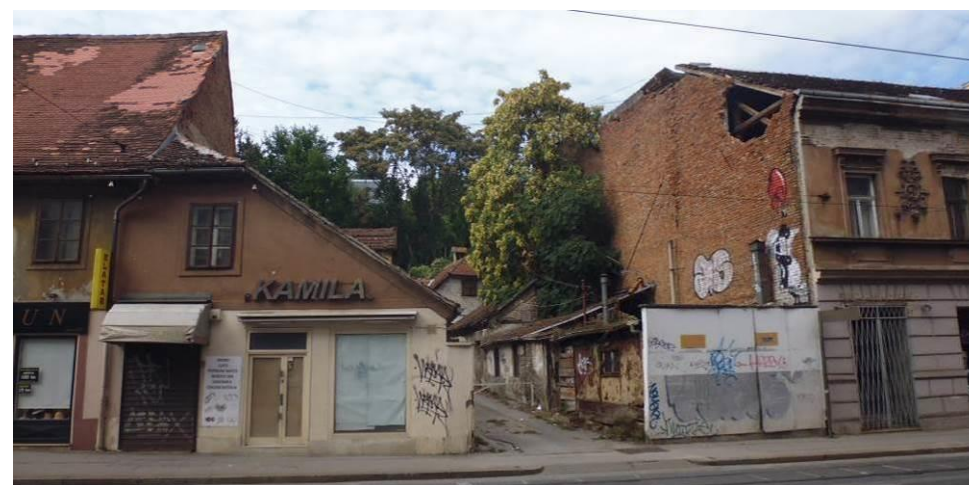
Slika govori više od riječi: pogled u neisplativu obnovu
