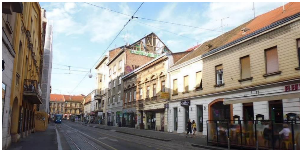
Potres u Zagrebu, 22. 3. 2020. (oštećena zgrada u Frankopanskoj ulici)
