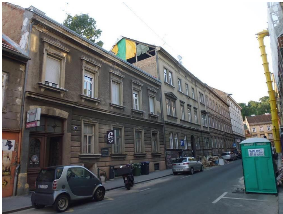
Potres u Zagrebu, 22. 3. 2020. - oštećena zgrada u Medulićevoj ulici
