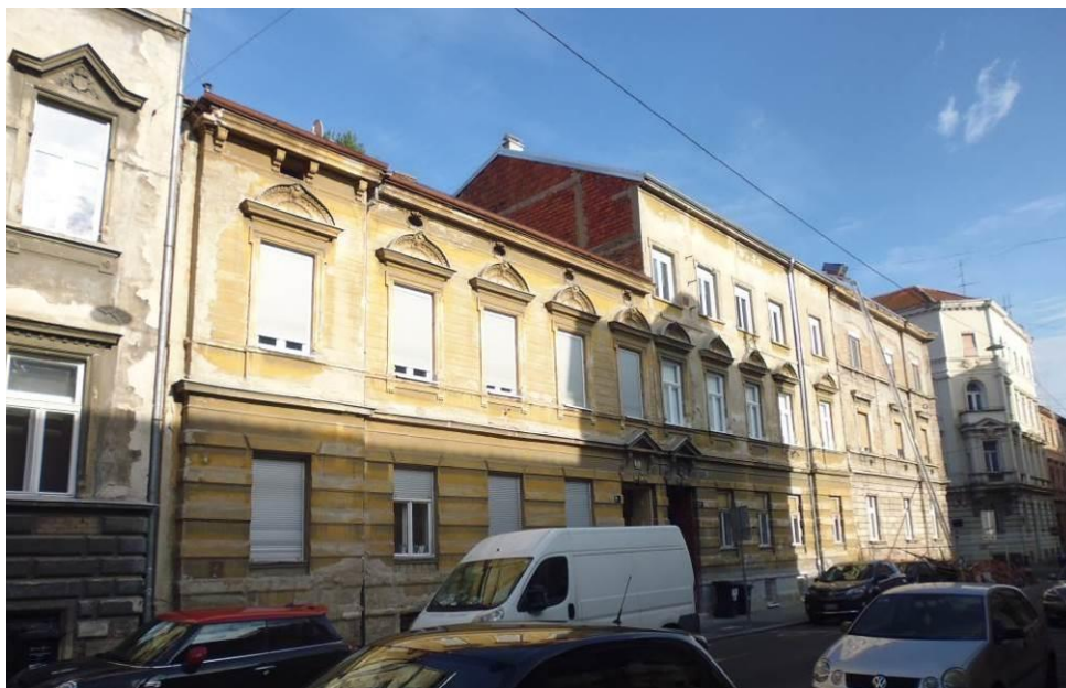
Medulićeva 11, jedna od najizglednijih zgrada s potencijalom dogradnje dodatne etaže u Bloku 19
