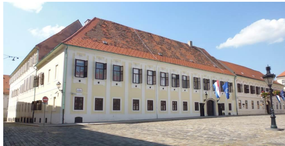
Zgrada Vlade Republike Hrvatske oštećena u potresu – Možda je potres onaj "okidač" koji će izazvati ozbiljne rasprave o izgradnji modernom vremenu primjerenog Nacionalnog upravnog centra u koji bi se preselile sve ključne političke institucije, a zgrade Hrvatskog sabora i Vlade pretvorile u povijesne muzeje i mjesta ekskluzivnih kulturnih i svečanih političkih događanja
