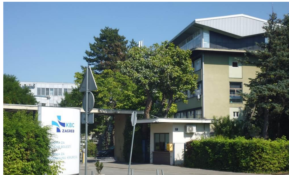
Zgrada bolnice Jordanovac neupotrebljiva nakon potresa
