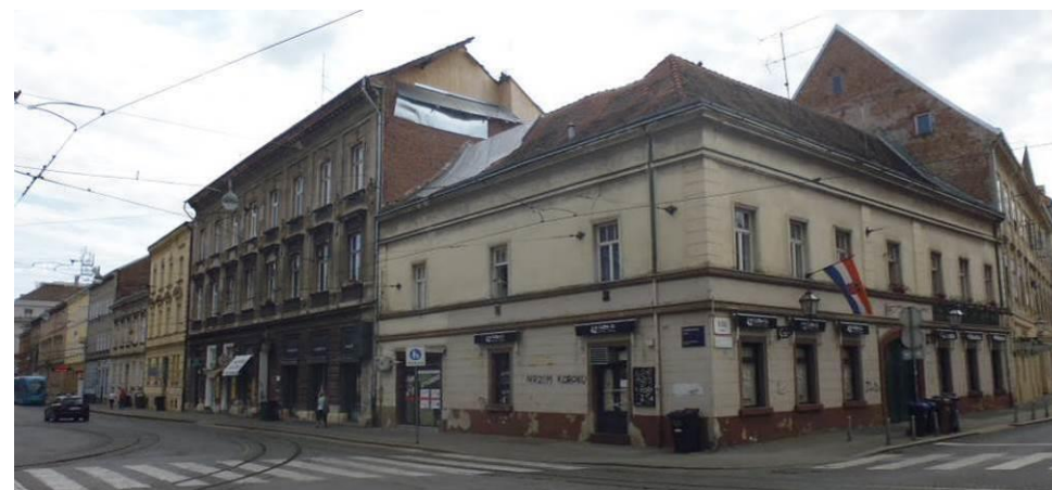
Potres u Zagrebu, 22. 3. 2020. - oštećene zgrade u Draškovićevoj i Vlaškoj ulici
