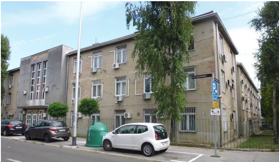
Ministarstvo uprave, sjeverna i zapadna zgrada
